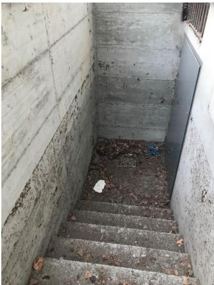
I pozzetti del sistema di raccolta delle acque meteoriche risultano ostruiti per la mancanza di manutenzione ordinaria. Ad esempio in corrispondenza della scala di accesso esterna agli archivi del Tribunale si verificano sovente fenomeni di allagamento in caso di pioggia.
