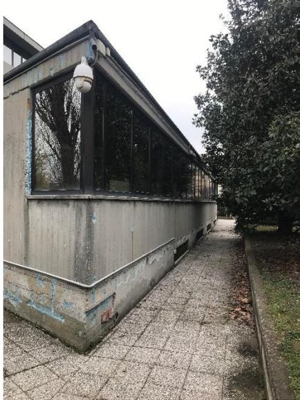
La parete dell'edificio è solo in parte distaccata dal terreno tramite un'intercapedine di circa 40 cm di spessore come mostra l'immagine a sinistra. Per quanto riguarda il resto del perimetro non sono presenti forme di contenimento dell'umidità e in alcune zone, come la rampa sulla destra, l'acqua piovana passa attraverso le aperture del piano seminterrato.
