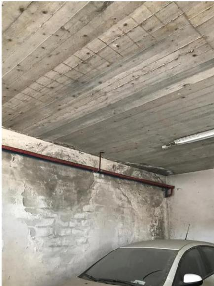
Le immagini mostrano l'avanzato stato di degrado che si riscontra in corrispondenza delle infiltrazioni ai piani seminterrati. In particolare si possono osservare l'archivio sottostante gli uffici della cancelleria penale sulla sinistra e le autorimesse sul lato del cortile retrostante l'ingresso principale sulla destra.
